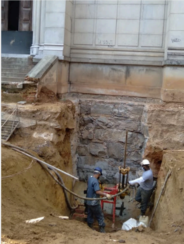
Prospecção estrutural e arqueológica na fachada lateral da catedral, voltada para a Av. Ipiranga. Fonte: Tribuna de Petrópolis, 2021.
