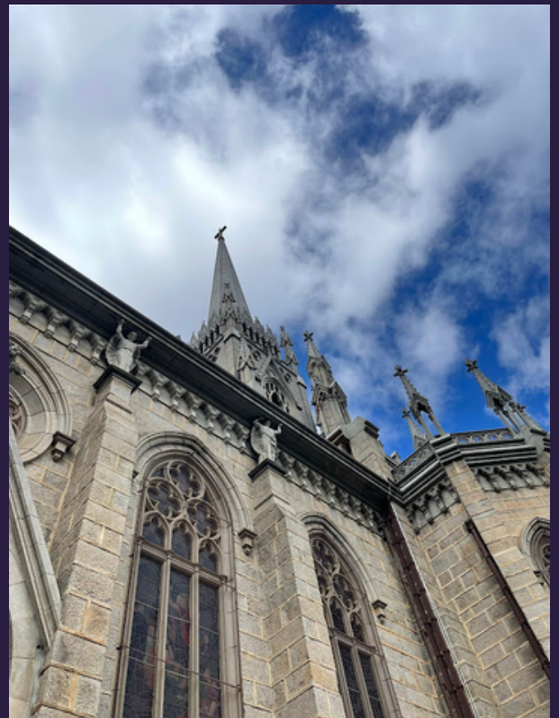
Detalhe da fachada lateral da Catedral, vista da Av. Ipiranga. Fonte: Lopes; Campbell; Araujo; Lott, 2023.
