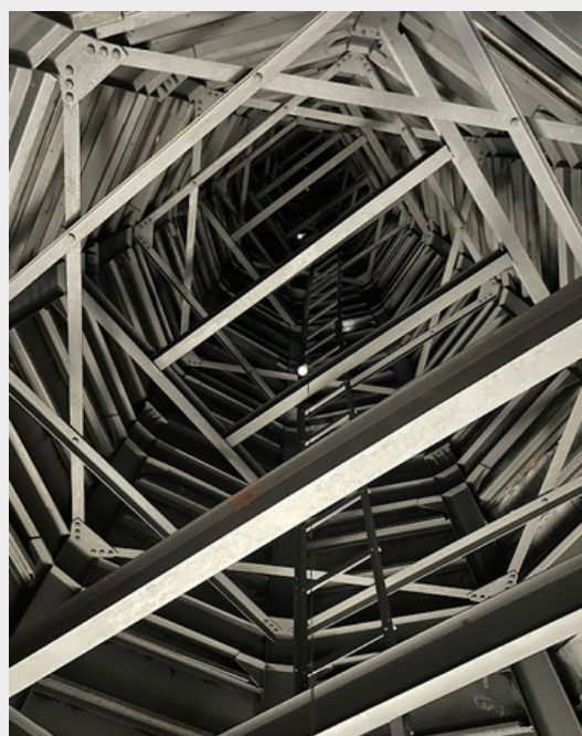
Detalhe da estrutura interna da agulha, o telhado da torre. Fonte: Lopes; Campbell; Araujo.; Lott, 2022.
