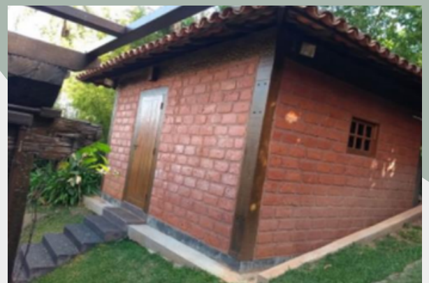
Casa com alvenaria em adobe. Fonte: Casa de Adobe, 2022.
